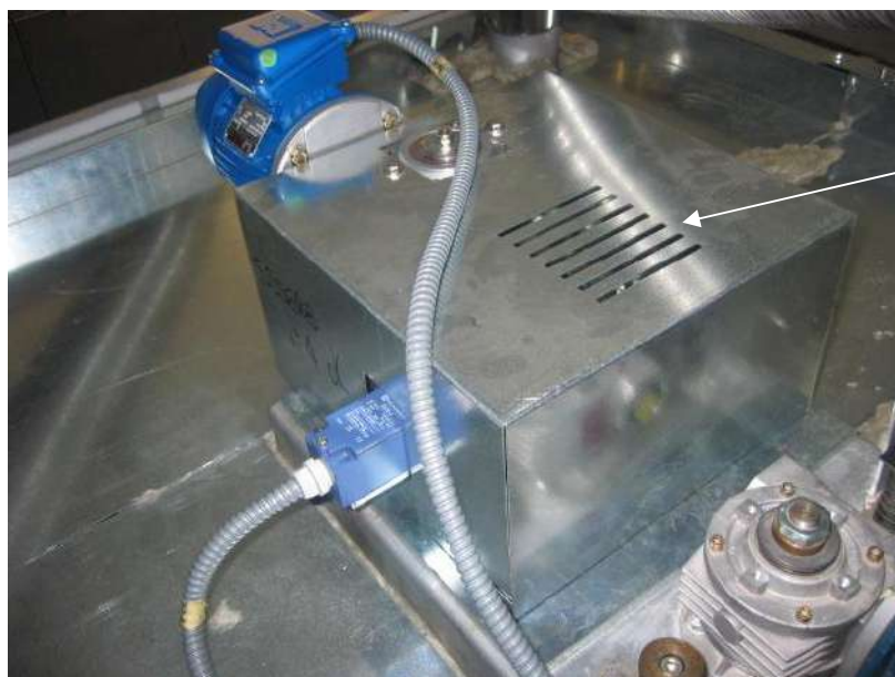
защитный кожух поворотного механизма
